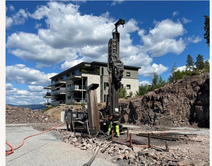
Dypere energibrønner for 30 leiligheter i boligprosjekt i Hole kommune
